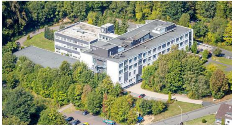
Soll weiterhin in Betrieb bleiben: Das Krankenhaus Kredenbach, das wegen der Pandemie wieder reaktiviert wurde.
